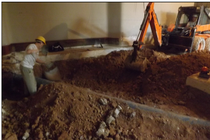
Vista del nivell d'argiles UE 102 a l'esquerra i a la dreta el seu rebaix fins a cota d'afectació
