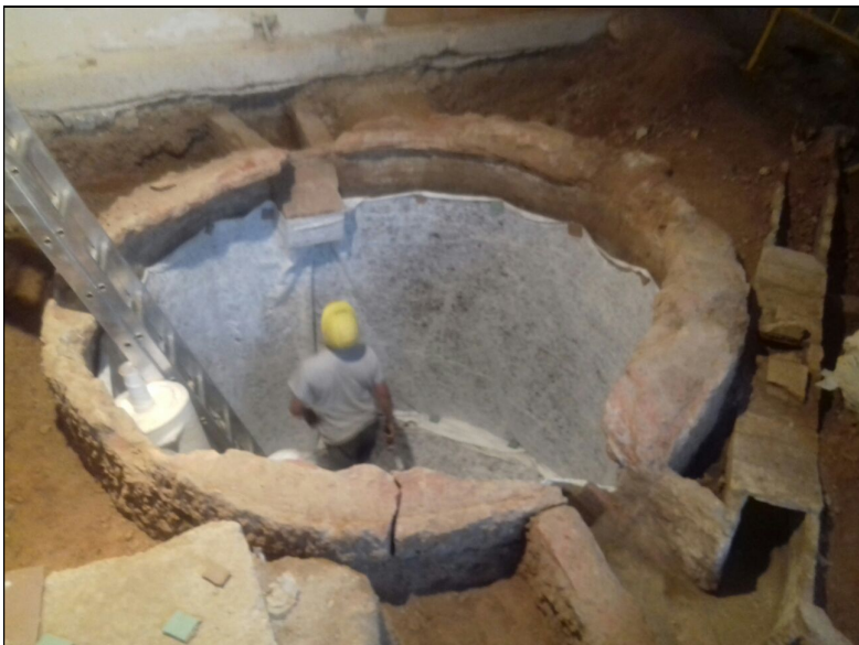
Protecció de l'element amb geotèxtil
