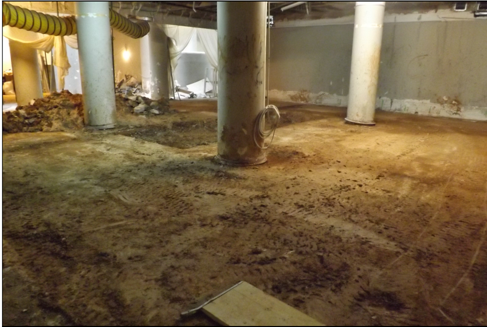
Dues vistes del Sector 1 a l'inici del rebaix un cop afectat el planxet de formigó
