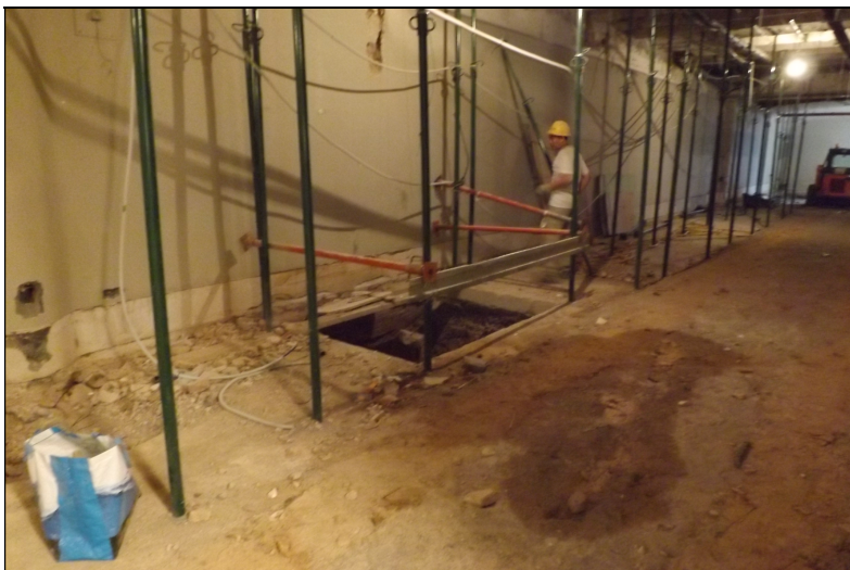
Vista del Sector 2 amb el pou per l'ascensor
