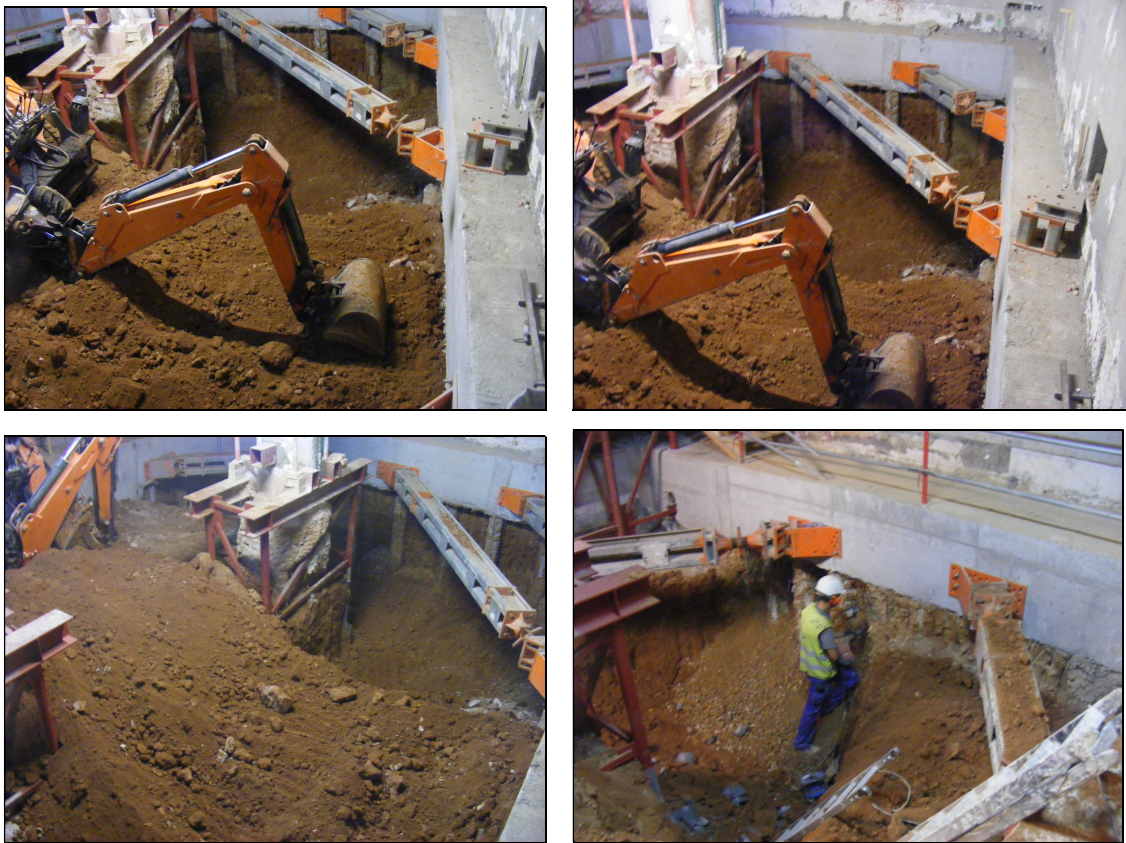
Diferents imatges del rebaix realitzat al Sector 3
